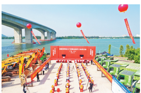
10月9日，深江高鐵正式開工建設。圖為江門開工動員活動現場。楊興樂攝
